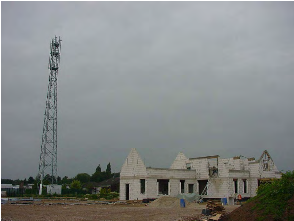
Rohbau neben dem Mobilfunk-Sendemast
