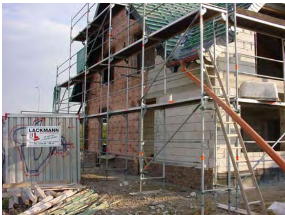
Verkleidung der Außenwände mit Kupfer-Abschirmgewebe
