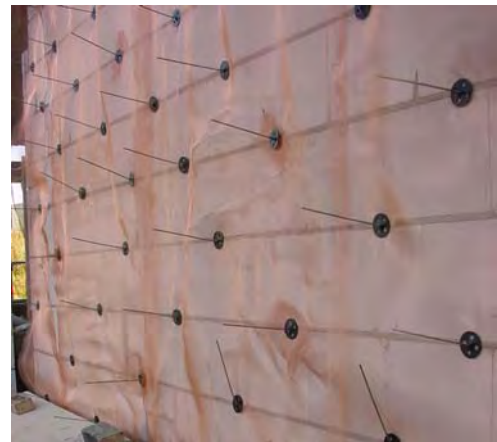
Befestigung des Abschirmgewebes auf den Luftschichtankern
