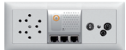
Abb. 3: Schweizerische 230V-Steckdosen (3-fach), ONT/ONU und Fernseh-Anschlussdose (v.l.n.r.) Foto: casacom [2]
